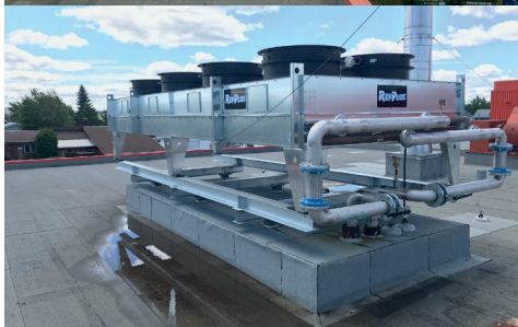
École secondaire Le Tremplin : installation de la climatisation
